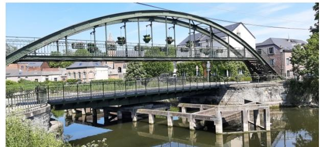
La passerelle, accessible par des escaliers métalliques, se compose de 2 poutres métalliques en arc. Le pont est de type tournant, c'est-à-dire qu'il pivote autour d'un axe vertical situé au milieu du canal.
