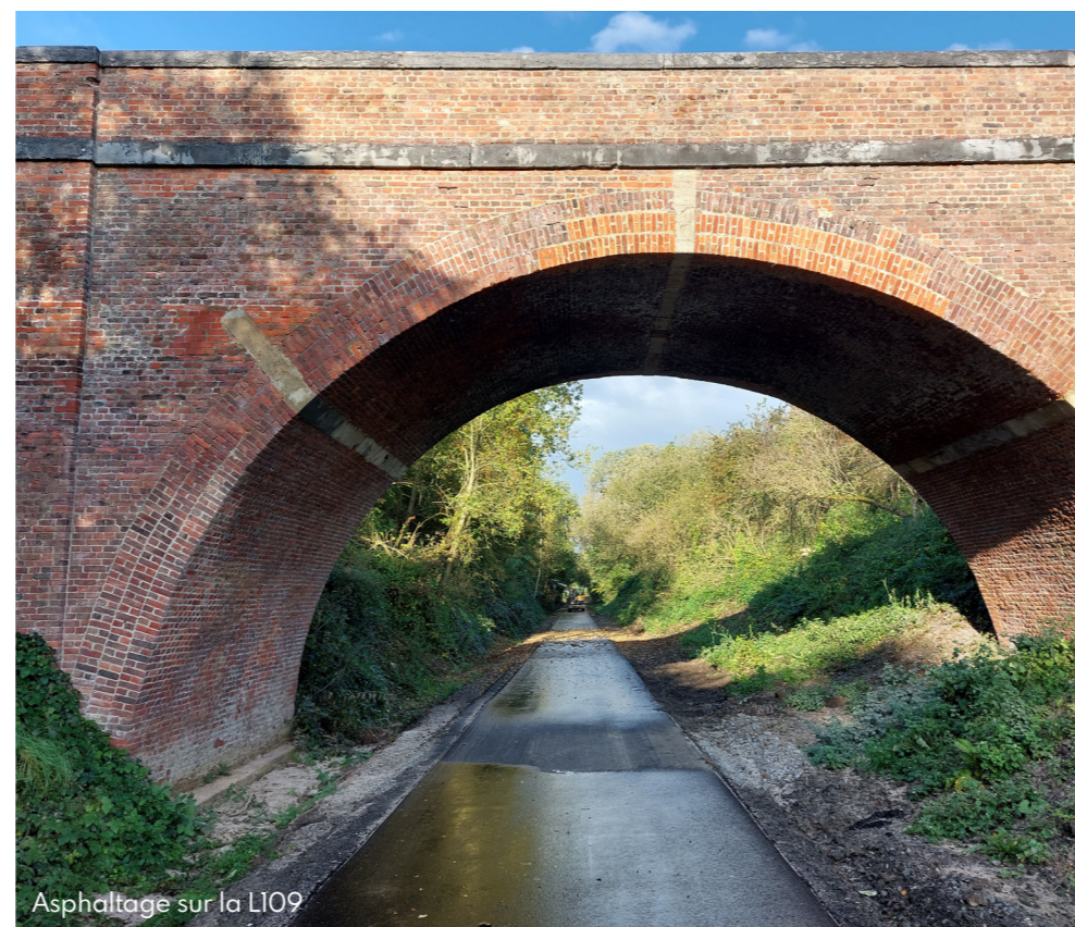
Préparation de l'assise du RAVeL sur la L109 en vue de l'asphaltage
