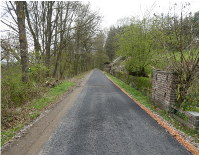
L44A tronçon Stavelot Francorchamps, la première couche d'asphalte est posée
