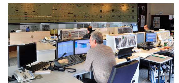
Cabine de signalisation 'tout relais' d'Aarschot, dernière de ce type chez INFRABEL
